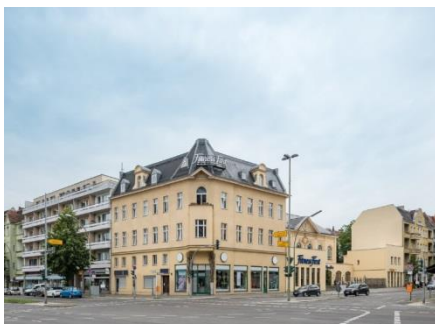
Tempelhofer Damm / Friedrich-Karl-Straße
